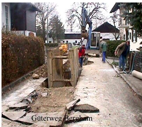
Im Zuge der Sanierung wurden die Stränge entweder gänzlich erneuert oder durch Einziehen von Schläuchen neue Rohrwände geschaffen.
